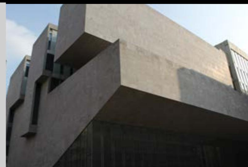
Il successo dell'edificio, si deve al ben risolto schema delle strutture portanti, costituite da grandi travi-parete. La distribuzione dei piani superiori risulta ben articolata e gli uffici danno un'idea di blocchi sospesi. Il blocco sotterraneo dell'edificio si
